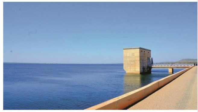
Après mise en eau
